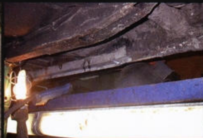
Laswerk aan de onderzijde
